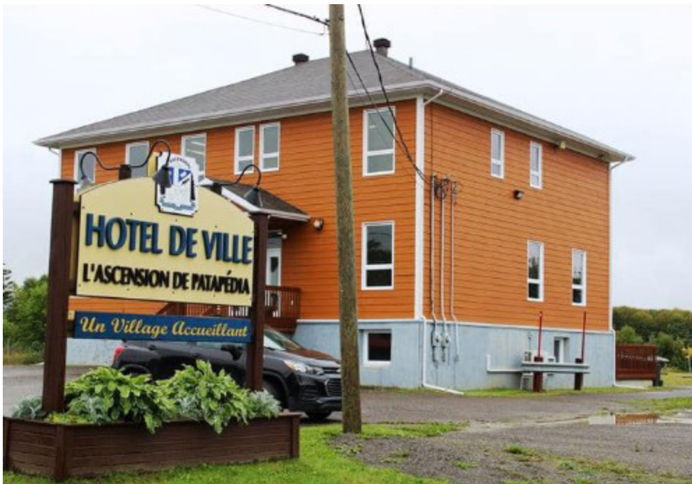
Figure 116 : L'ancienne école de L'Ascension-de-Patapédia, aujourd'hui l'hôtel de ville
