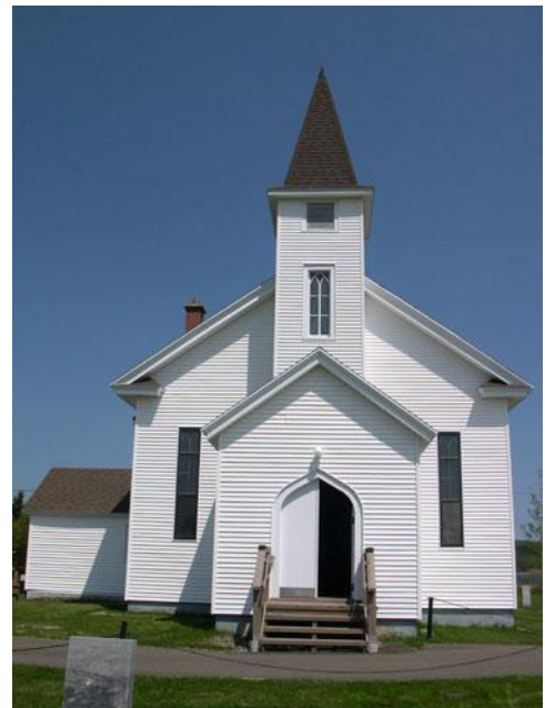
Figure 125 : L'église Escuminac's United, qui date de 1858
