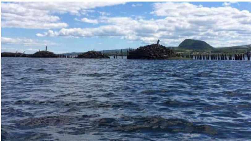
Figure 73 : Des vestiges d'estacades forment des mini-îles ensablées à Pointe-à-la-Croix, en 2023
