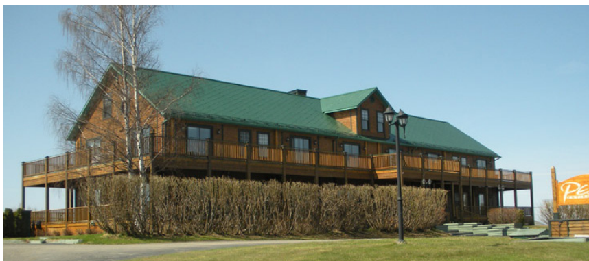
Figure 63 : Le bâtiment de PESCA Environnement à Carleton-sur-Mer, ancienne « cook room » de la Madawaska Lumber Co
