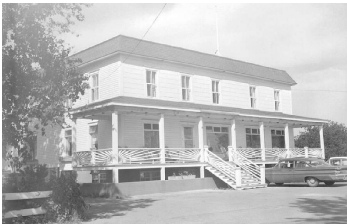
Figure 154 : L'hôtel Fleur de Lys, à Saint-Omer, après sa rénovation, en 1961
