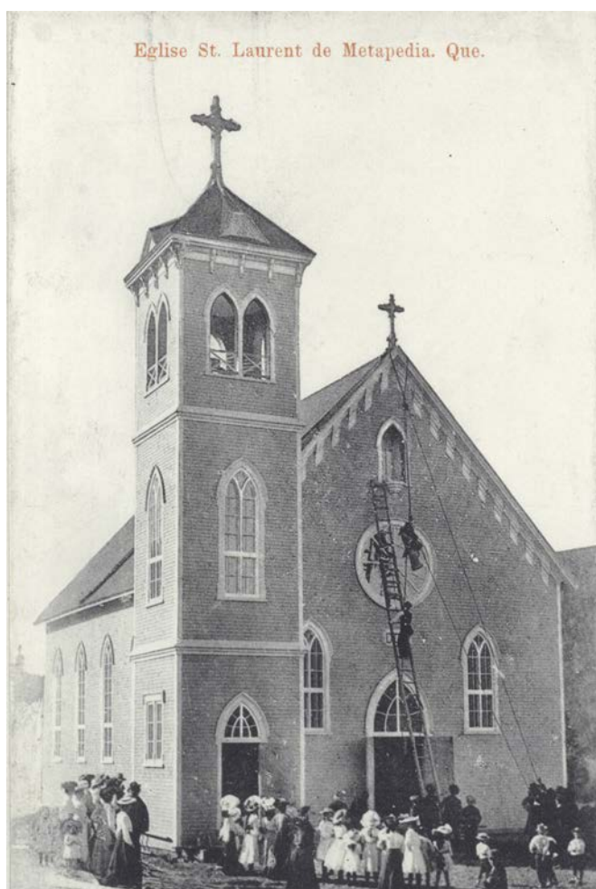
Figure 117 : L'église de Matapédia, construite en 1903
