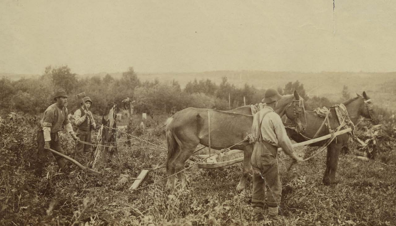
Figure 169 : Des chevaux tirant des souches d'arbres à Saint-André-de-Restigouche vers 1870
