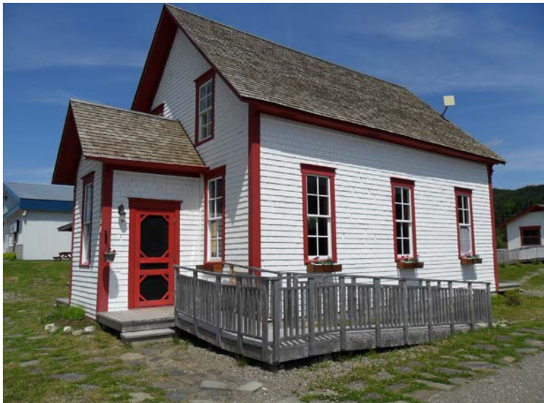
Figure 110. L'école de rang de Nouvelle aujourd'hui, construite entre 1907 et 1908
