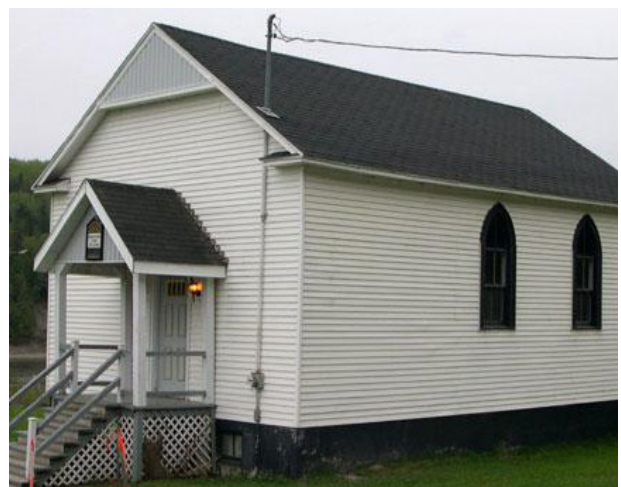
Figure 128 : L'église Moore Settlement United Baptist, à Matapédia, construite en 1911
