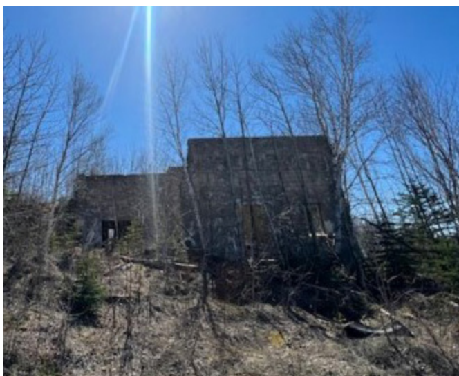
Figure 145 : Les possibles vestiges du concasseur de Nouvelle, en 2022
