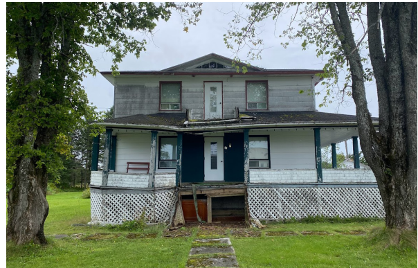
Le presbytère de L'Ascension-de-Patapédia en 2022 Source : Camillia Buenestado Pilon.
