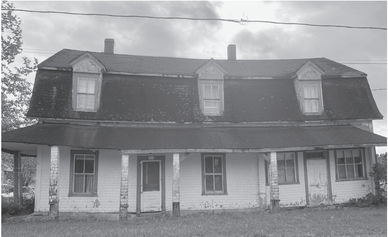
Un bâtiment qui s'apparente à un ancien magasin général, à Saint-Alexis-de-Matapédia
