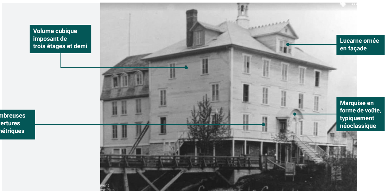
Le couvent de Carleton, un bâtiment cubique avec un agrandissement mansardé, en 1903
