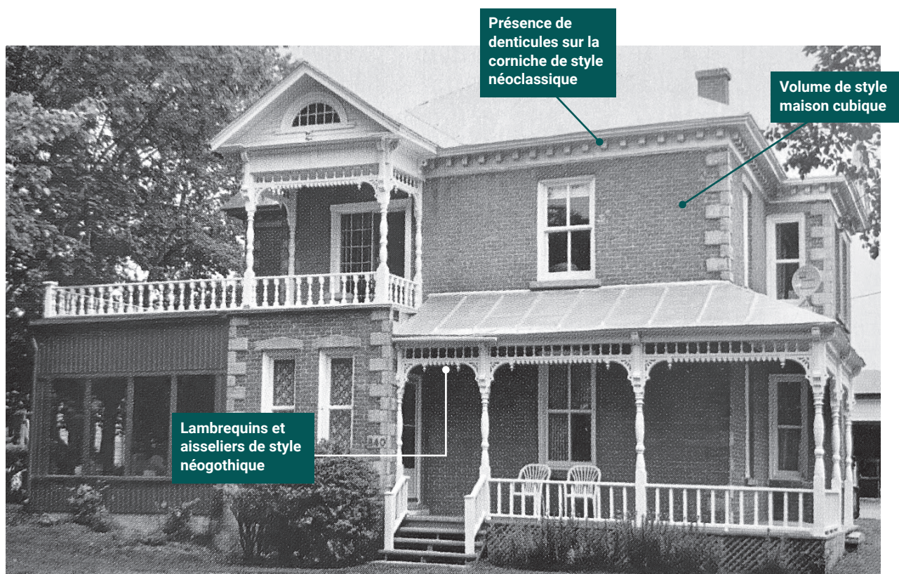
La maison Monti, à Carleton, construite vers 1900
