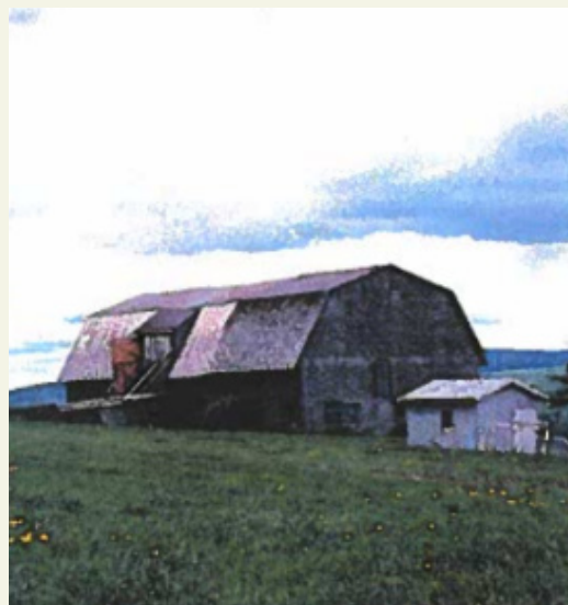
Une grange à toit brisé située au 75, route Lagacé, à Saint-André-de-Restigouche, en 1998
