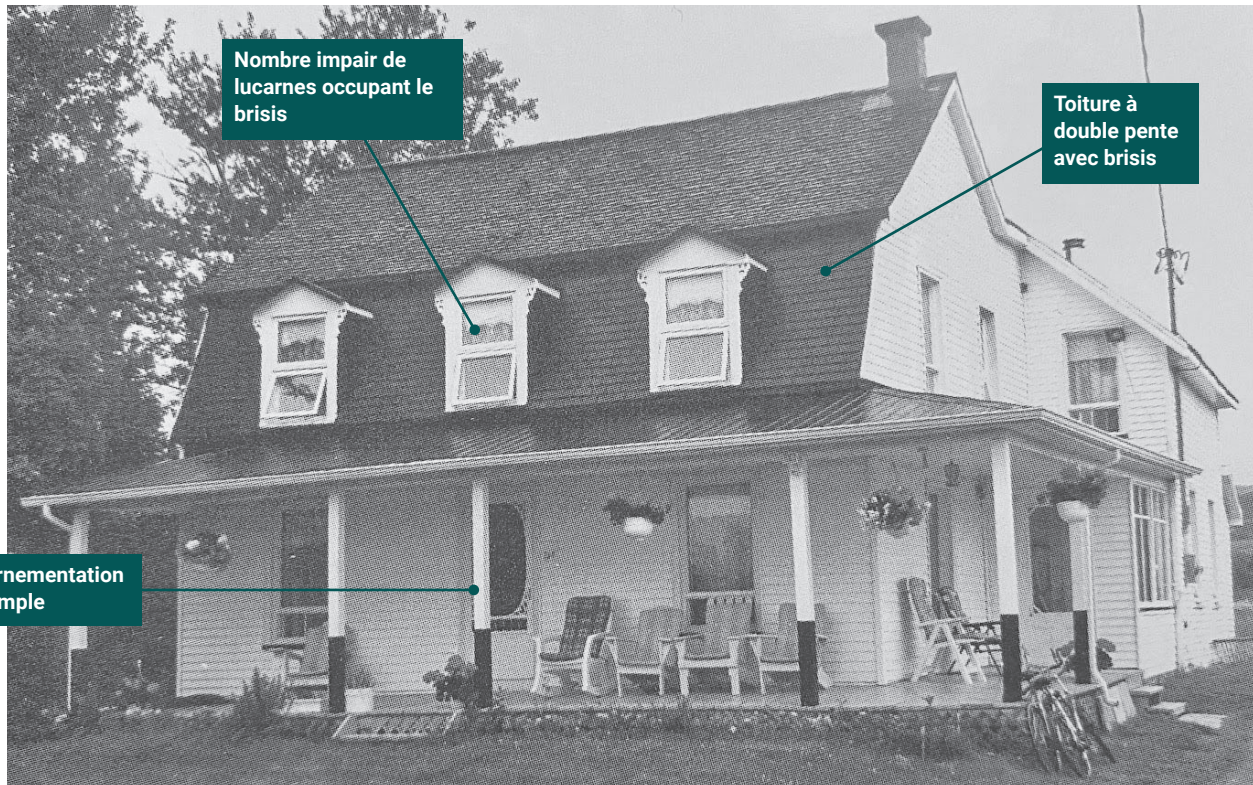
La maison Augustin Lepage, située au 264, route 132 Ouest, à Saint-Omer
