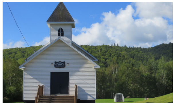
L'église Mann Settlement United Baptist, à Matapédia, construite en 1911 Source : inconnue.
